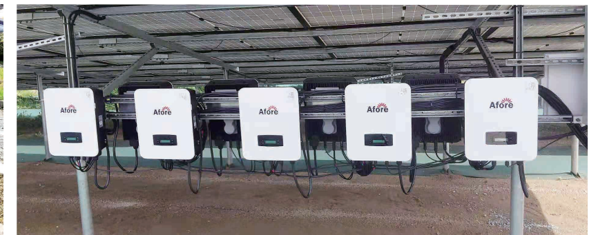
49.5kW 福岡県大川市
