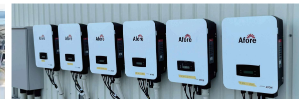
9.9kW 蓄電池:85.2kwh 59.4kW 福岡県
