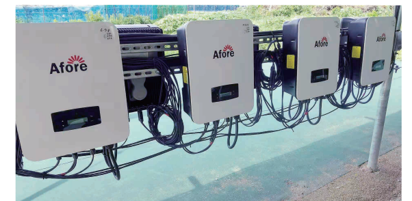
49.5kW 福岡県大川市
