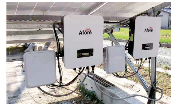
49.5kW 福岡県大川市
